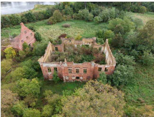
035. Ruina dworu w Mieszynie
