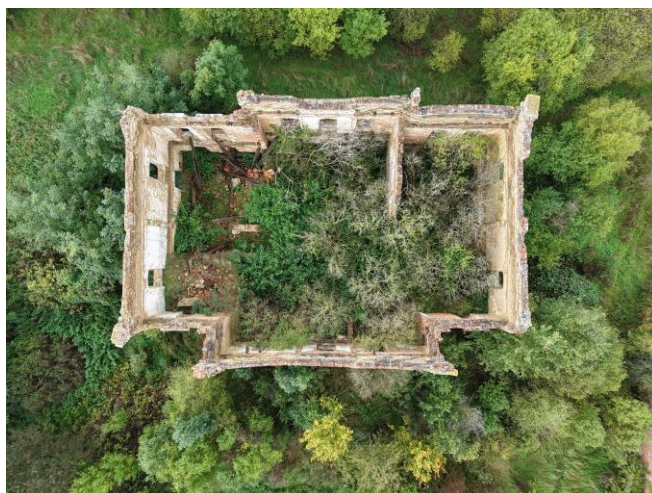
038. Ruina dworu w Mieszynie
