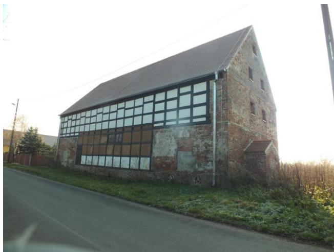
016. Częściowo wyremontowany spichlerz w Droglowicach, 2022
